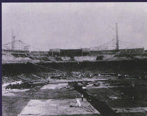
建設中の後楽園スタジアム
